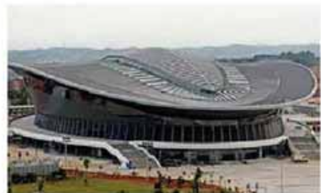
广西体育中心项目
