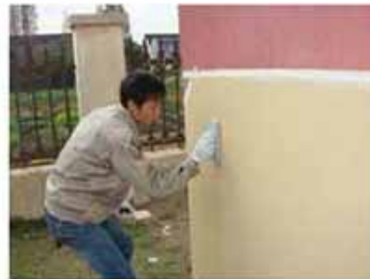
无机饰面砂浆打磨
