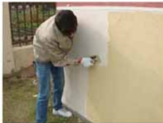
无机饰面砂浆刮抹
