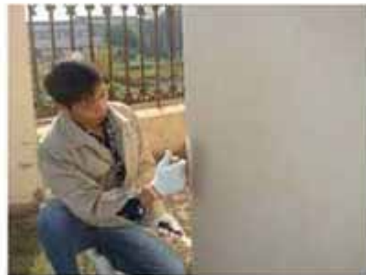
无机抗渗界面剂施工
