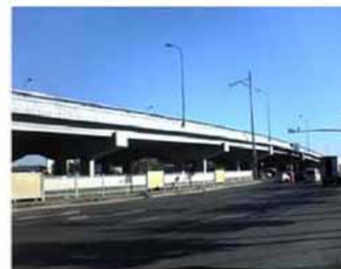
2008奥运会二、三、四环立交桥桥梁粉刷
