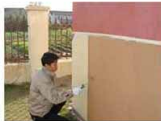
无机粉末涂料施工
